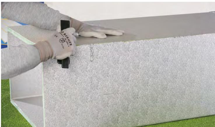
Cerrar los lados del conducto hasta obtener la forma final; ayudándose con la espátula rígida comprimir los bordes para lograr la unión.
